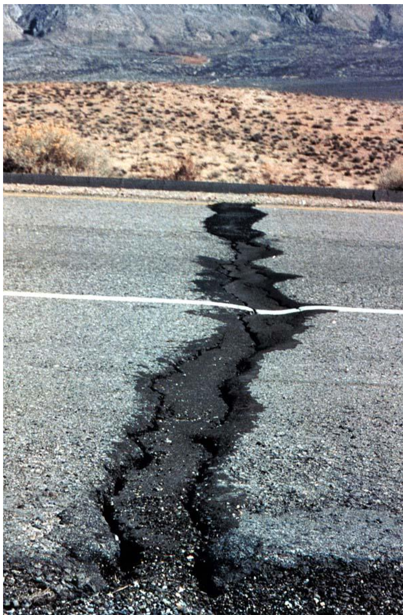
شکل ۲-۶: ترک حرارتی در مسیر راه [۵۲]
