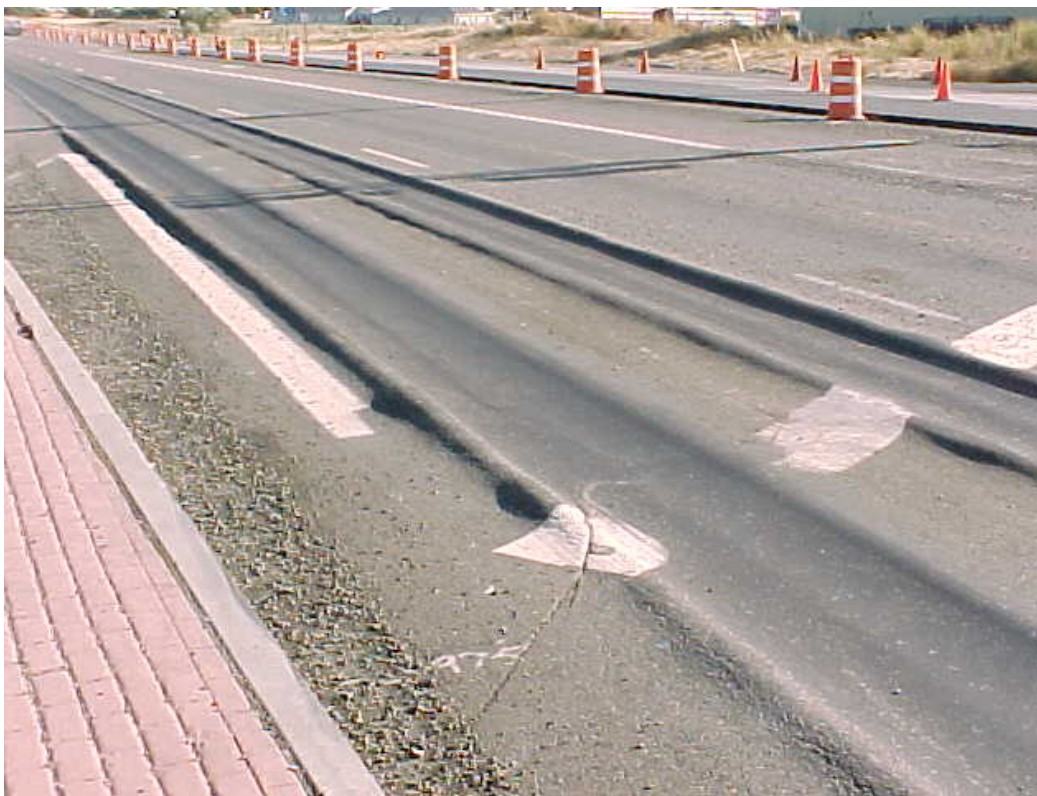
شکل ۲-۴: خرابی شیارافتادگی در مسیر راه [۵۲]
